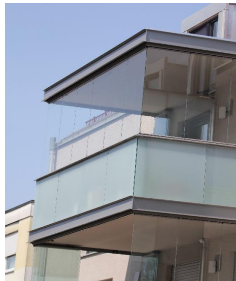
Mit Klarglas umschlossener Balkon, der Vögel zum Durchflug verleitet. Schwach sichtbar sind nur die Verbindungen zwischen den Glasscheiben.
