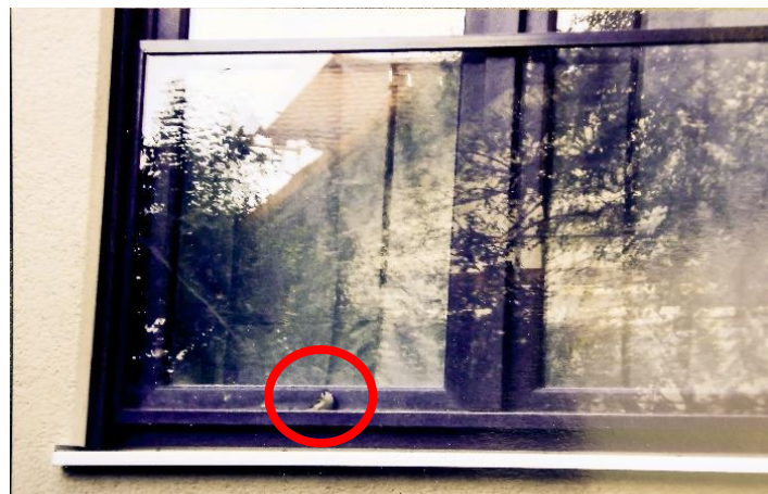
Mit Klarglas umschlossener Balkon, der Vögel zum Durchflug verleitet. Schwach sichtbar sind nur die Verbindungen zwischen den Glasscheiben.
